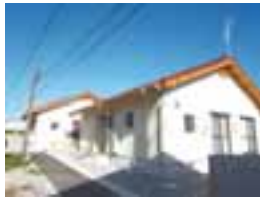
完成した宮の前団地
